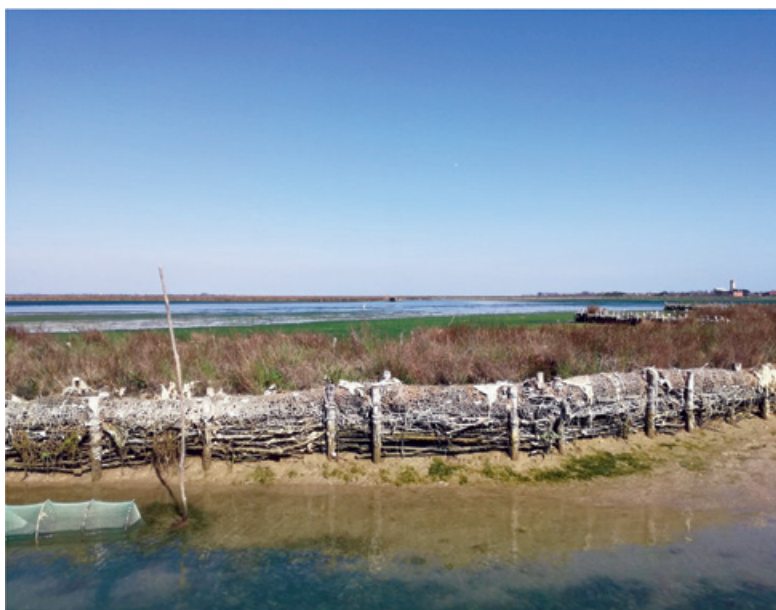
Figura 8: Barrera de feixines durant la marea baixa (autor C. Ferrari).
