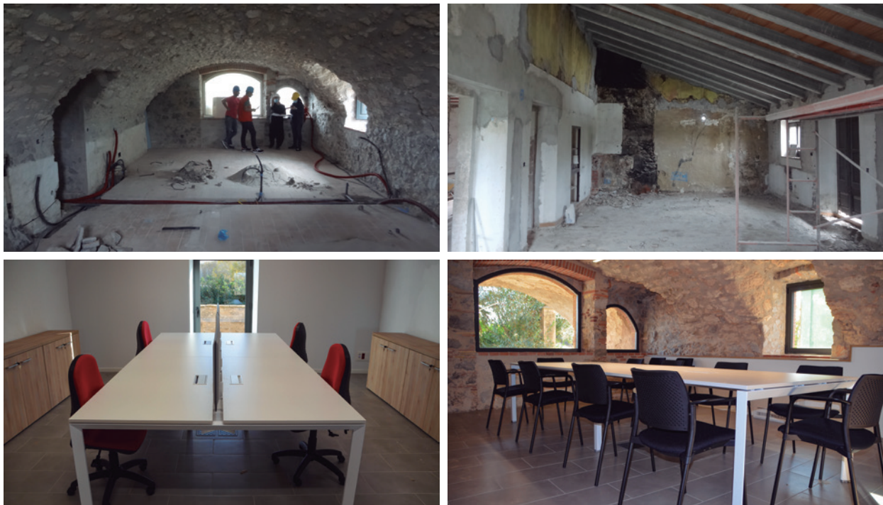
Figures 6,7,8 i 9.- Imatges del procés de rehabilitació i adequació de les dependències del Mas Badia (6 i 7). Imatges d'algunes dependències després del procés (8 i 9) amb el mobiliari definitiu.
