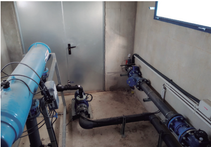
Figures 19, 20 i 21.- Detalls de la caseta de reg amb els diferents components del sistema i imatge del variador de freqüència, peça clau de la conversió de corrent continu que produeixen les plaques fotovoltaïques a energia alterna que utilitzen els diferents components elèctrics de la instal·lació.
